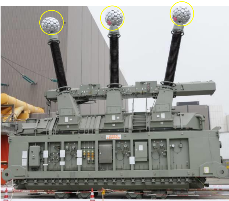
Трансформатор атомной станции мощностью 1.1 ГВА с экранированными вводами
